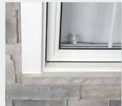
Finition avec allège de fenêtre, moulure et jambage
