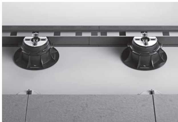
Posizionamento profilo sui supporti Positioning of the profile on the supports
