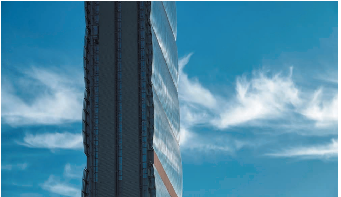
Torre Allianz – Rooftop, terrazze e aree esterne Milano, Italia Pedestal System – Eterno SE
